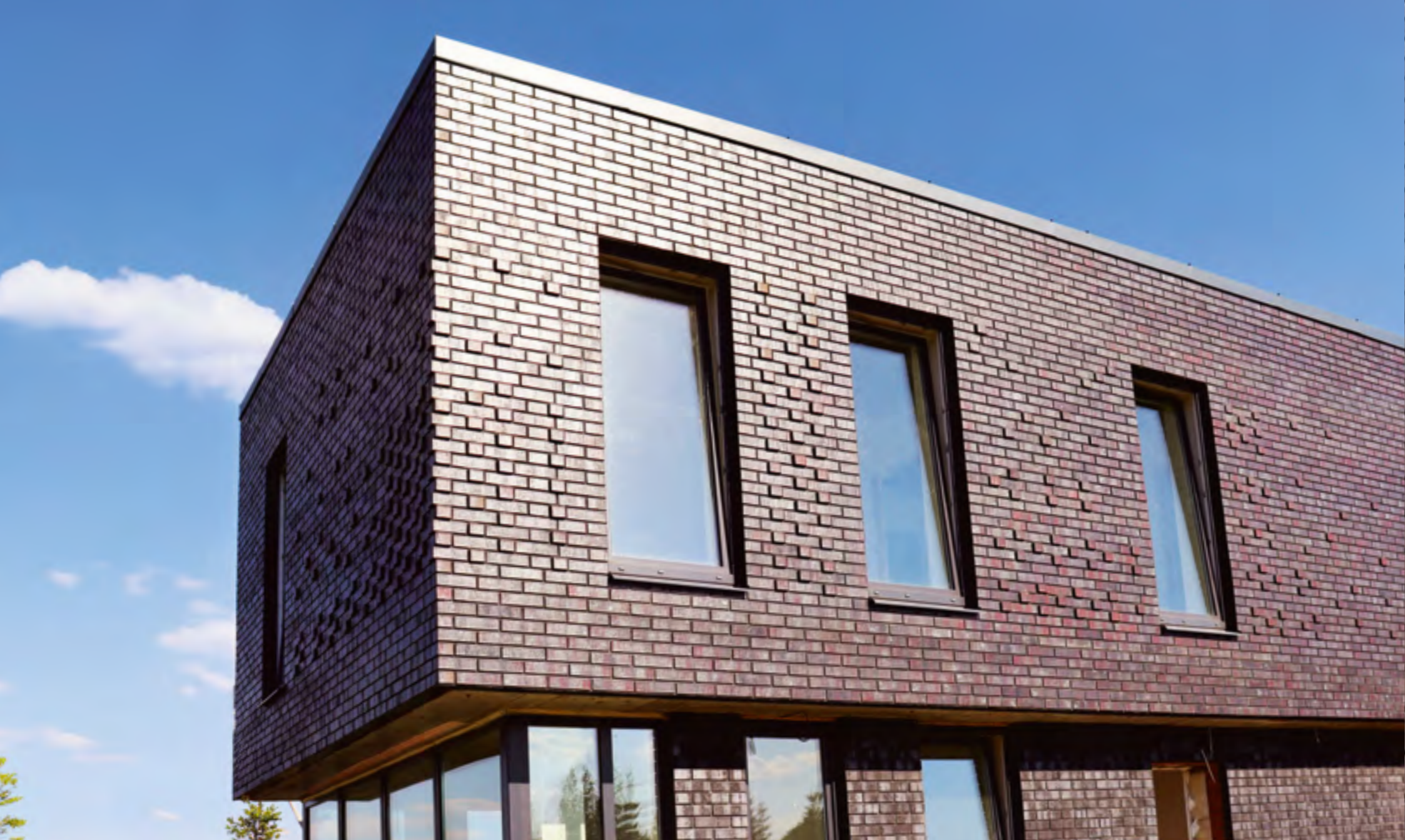
г. Казань КП «Европа», частное домостроение
