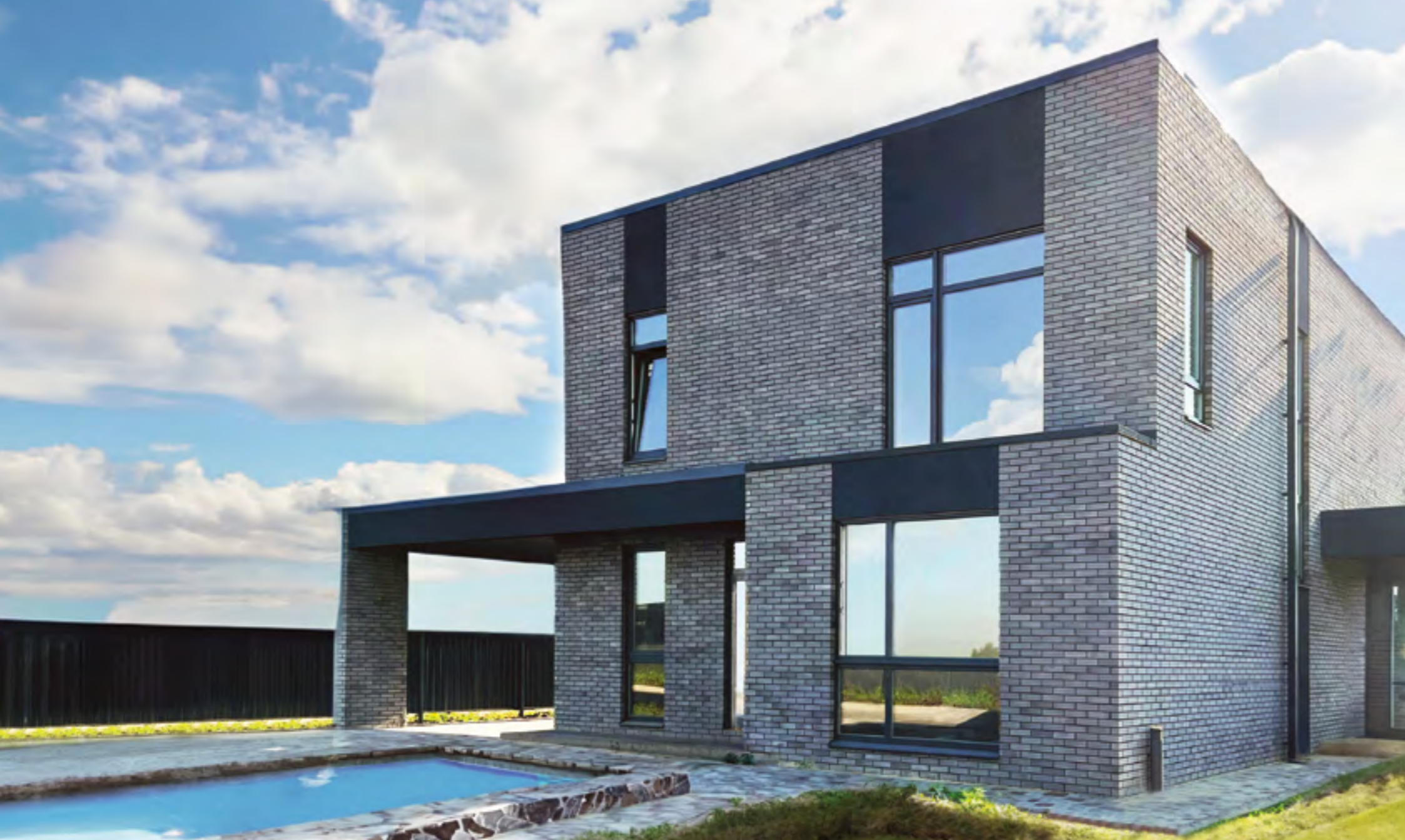
г. Казань КП «Европа», частное домостроение
